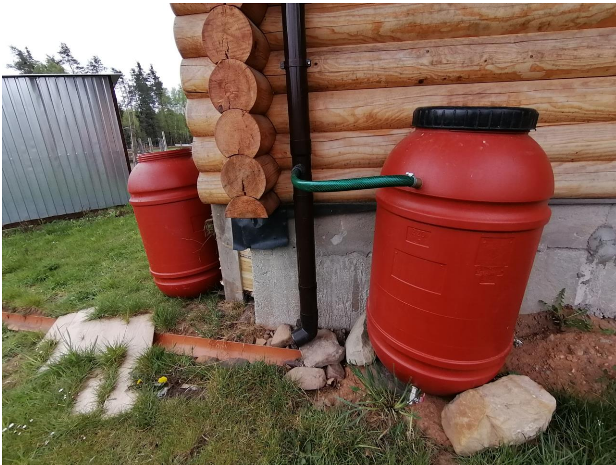
Zbiornik na deszczówkę gromadzący wodę z dachu budynku, przyłączony do rury spustowej przy pomocy zbieracza deszczówki
